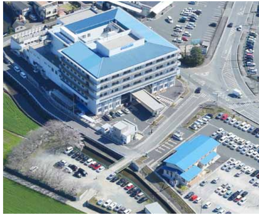
▲上益城郡嘉島町鯉の新病院建設から8年、ポストコロナの受け入れ体制の再整備が急務だという
